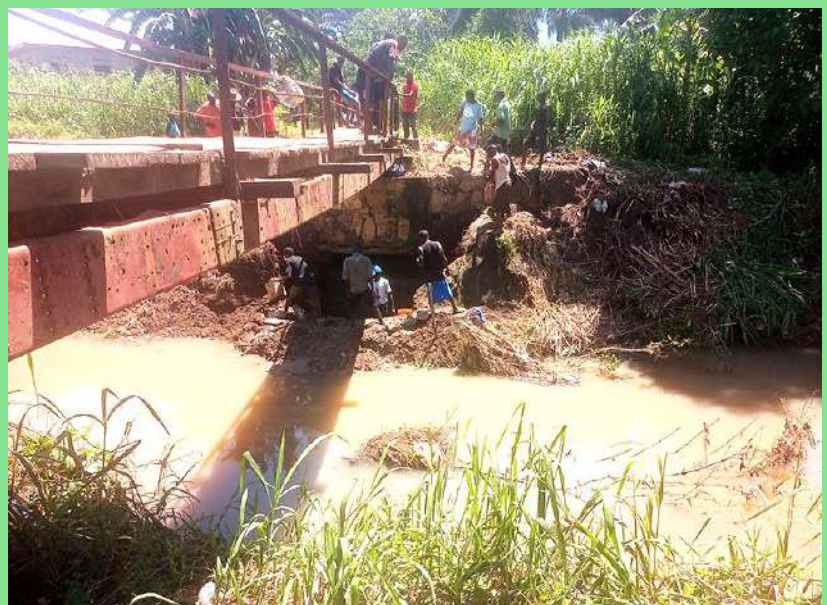
Consolidation de la passerelle de Sindi contre les inondations
